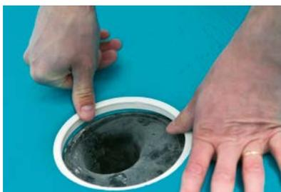
**7.** Zamáčknout napínací kroužek. Odříznout přebytečný Kerafiber.
