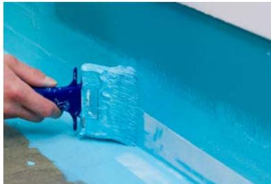
2. Překrýt rohy, spoje z různých podkladových materiálů a hlavy šroubů páskou Kiilto Nurkkavahvikenauha. Pásku vložít do mokrého KERAFIBERU a nanést druhou vrstvu hydroizolační fólie přes pásku, aby páska byla důkladně zvlhčena. Může se použít i prefabrikovaná rohová páska.
