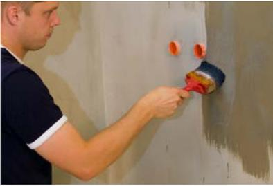
1. Suchou a bezprašnou stěnu natřít Kiilto Keraprimér ředěným vodou 1:1. Nechat zaschnout minimálně 1 hodinu před začátkem hydroizolace
