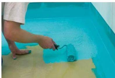
4. Válečkem nanést Kerafiber vodotěsnou membránu na podlahu a nechat zaschnout min. 2 hod / změni barvu
