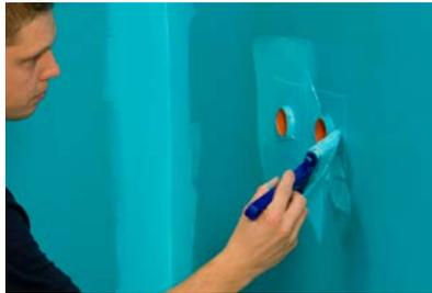
5. Nanést druhou vrstvu KERAFIBER a před obkladem počkat 6-12 h / změna barvy. Zkontrolovat tloušťku vrstvy KERAFIBERU, přidat KERAFIBER na tenkých a/nebo porézních místech a nechat zaschnout. Celková spotřeba KERAFIBER by měla být min. 0,6 l / m<sup>2</sup> a tloušťka vrstvy 0,4 mm.
