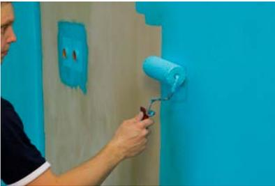
4. Válečkem nanést Kerafiber vodotěsnou membránu na stěnu a nechat zaschnout min. 2 hod / změni barvu
