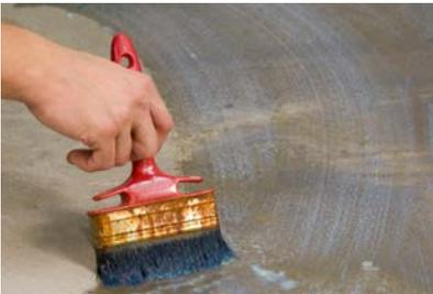
1. Válečkem nanést Kerafiber vodotěsnou membránu na podlahu a nechat zaschnout min. 2 hod / změni barvu
