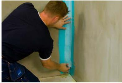
2. Před každým použitím Kiilto Kerafiber dobře promíchat. Překrýt rohy, spoje z různých podkladových materiálů a hlavy šroubů páskou Kiilto Nurkkavahvikenauha. Pásku vložít do mokrého KERAFIBERU a nanést druhou vrstvu hydroizolační fólie přes pásku, aby páska byla důkladně zvlhčena.
