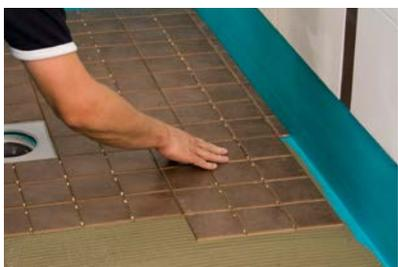
**12.** Fix floor tiles with Kiilto Superfix DF, Kiilto Saneerauslaasti or Kiilto Kerapid Pikasaneerauslaasti.
