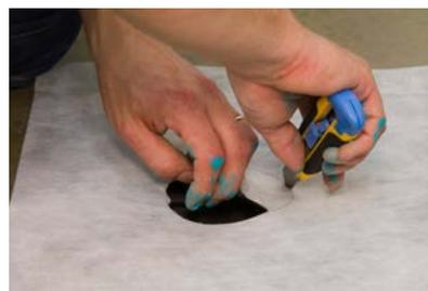
**8.** Alternativně může být odtok utěsněn samolepící výztuží Kiilto Kaivolaippa. Umístit výztuž na místo a přitisknout. Vyříznout otvor a zamáčknout napínací kroužek.
