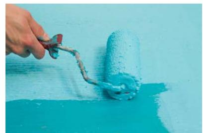
5. Nanést druhou vrstvu KERAFIBER a před obkladem počkat 6-12 h / změna barvy. Zkontrolovat tloušťku vrstvy KERAFIBERU, přidat KERAFIBER na tenkých a/nebo porézních místech a nechat zaschnout. Celková spotřeba KERAFIBER by měla být min. 0,8 l / m<sup>2</sup> a tloušťka vrstvy 0,5 mm.
